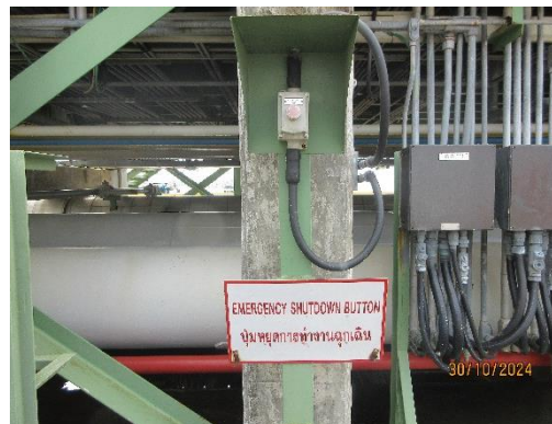
ภาพที่ 2-53 ระบบ Emergency Release System (ERS) บริเวณ Loading Arm ของท่าเทียบเรือ
