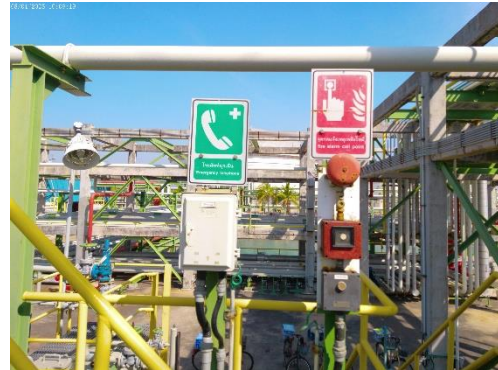
ภาพที่ 2-47 จุดบอกเหตุกรณีเกิดเหตุฉุกเฉิน บริเวณพื้นที่ท่าเทียบเรือ
