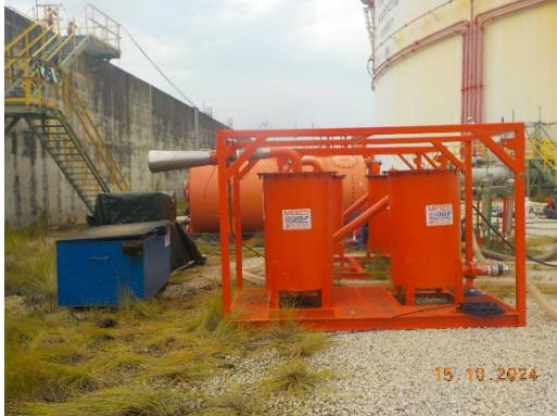
ภาพที่ 2-64 ระบบดูดซับไอระเหยของสารเคมีที่เกิดขึ้นจากกิจกรรมล้างถัง (Activated Carbon)
