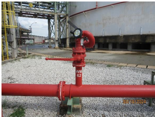
ภาพที่ 2-42 ระบบหัวฉีดน้ำดับเพลิง (Fixed Monitor)
