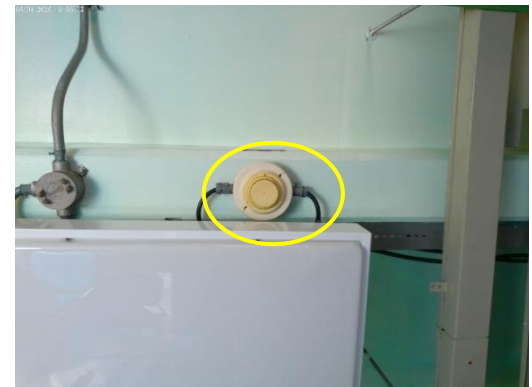
ภาพที่ 2-43 ระบบตรวจจับควัน (Smoke Detector)
