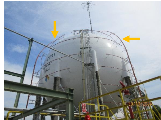
ภาพที่ 2-37 การติดตั้งระบบน้ำฉีดรอบผนังเพื่อลดอุณหภูมิ
