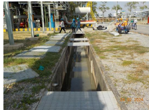
ภาพที่ 2-24 การล้างทำความสะอาดรางระบายน้ำ ก่อนเข้าหน้าฝน
