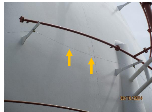
ภาพที่ 2-45 ระบบตรวจจับความร้อน (Linear Heat Detector)
