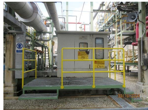
ภาพที่ 2-8 ตู้ควบคุมการทำงานของระบบ Boil of Gas (BOG)
