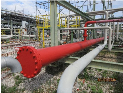
ภาพที่ 2-40 ระบบการสูบน้ำดับเพลิงเข้าถึงเก็บ ปิวทีน-1 และ C4's Derivative
