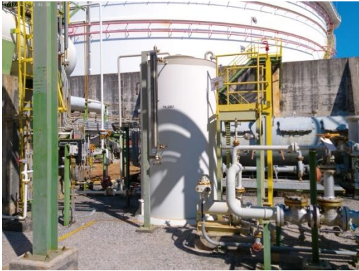
ภาพที่ 2-21 ระบบ API Separator
